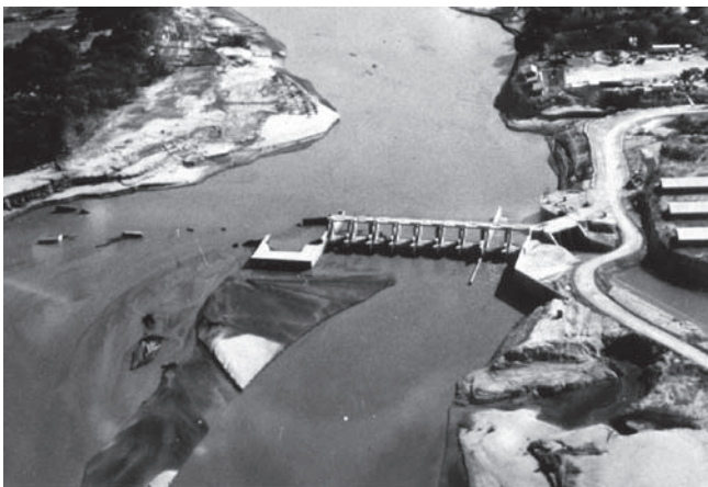
Ilustración 2. Falla de la presa Los Ejidos (1983), río Piura, Perú.
