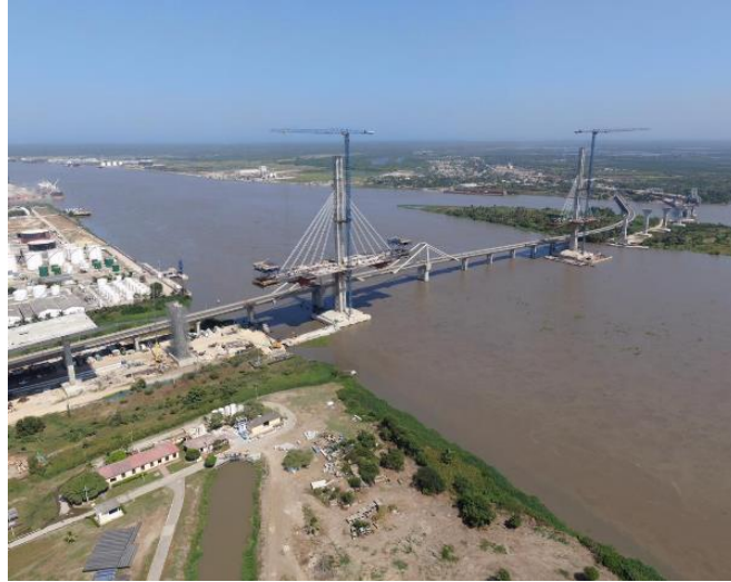
Figura 4. Imagen del puente Pumarejo, tomada el 20-04-2019 (Barranquilla, Colombia).
