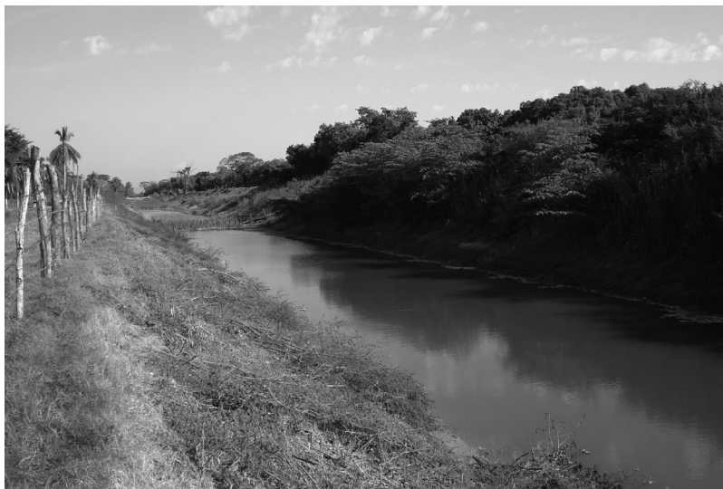
Figura 7. Dren del distrito de riego que descarga en las lagunas.
