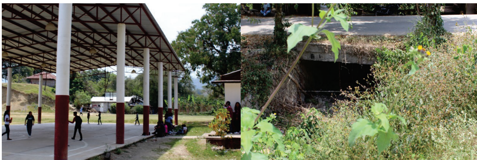
Figura 2. Fotografías de Aquismón. Izquierda: casa comunal de Santa Bárbara; derecha: puente vehicular junto a un asentamiento.
