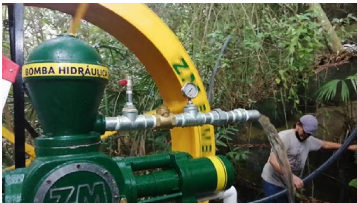
Figura 14. Puesta de accesorios de la tubería de descarga.
