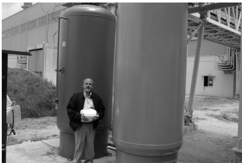
Figura 6. El autor junto a los dos tanques de 792 galones ( $2.99 \text{ m}^3$ ) citados en el ejemplo.
