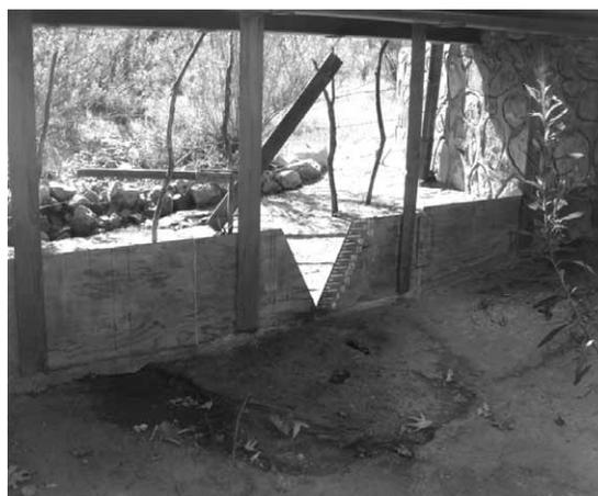
Figura 2. Vertedor triangular de pared delgada.
