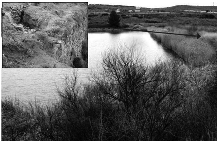
Figura 8. Erosión superficial causada por el desbordamiento de una presa de muro construida en 1552 (presa Ontígola, España).
