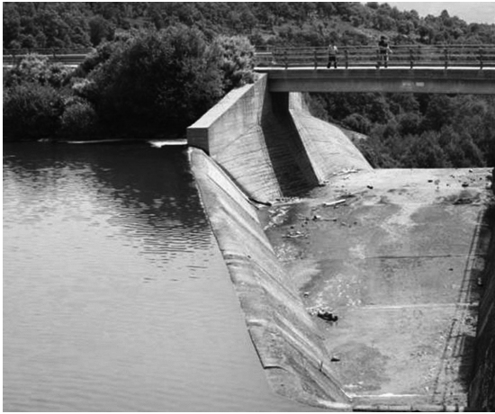
Figura 2. Árboles detrás de un muro de concreto reforzado, que es un contrafuerte del puente del canal del vertedero. (Presa Santa Lucía de la Sierra, España).
