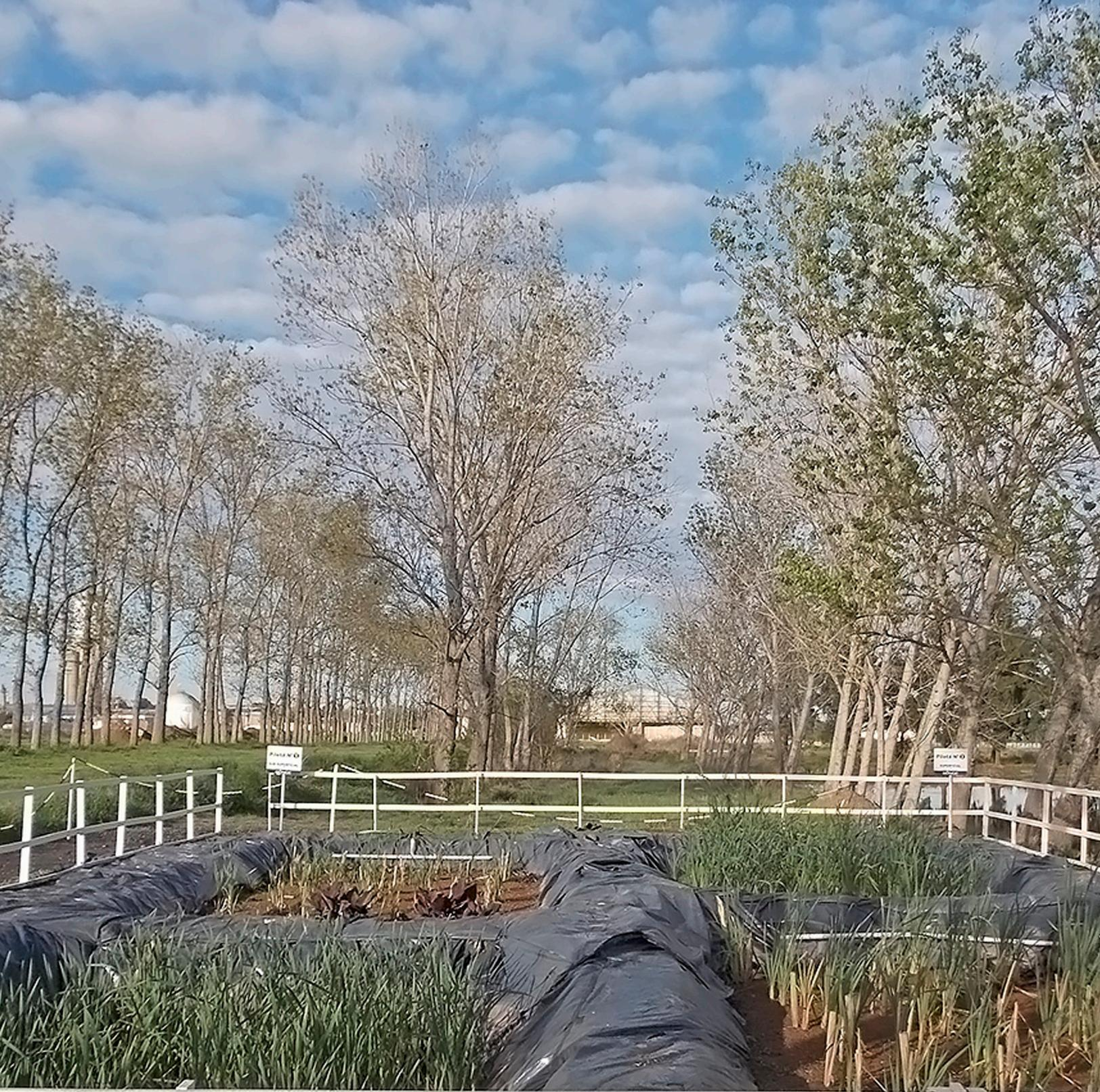
Sistema de humedales de tratamiento construido en el predio de una fábrica de fertilizantes nitrogenados para tratar sus efluentes. En estos humedales se plantaron las especies *Typha domingensis* (Totora) y *Canna indica* (Aschira). Es un sistema híbrido, ya que comprende humedales de tipo de flujo subsuperficial horizontal y de flujo libre.
