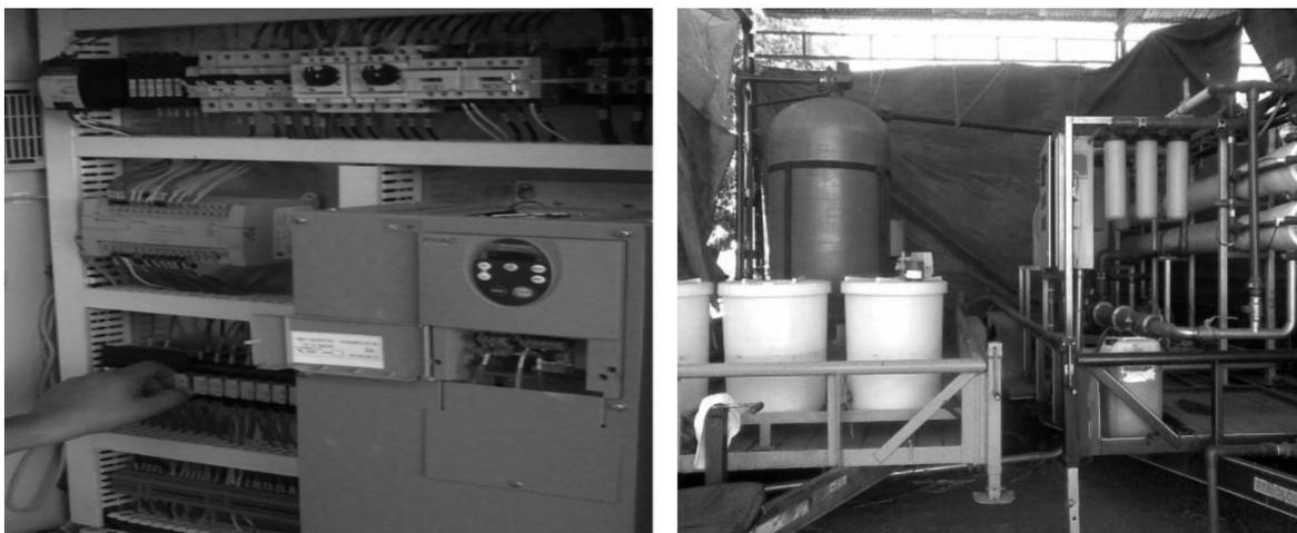
Figura 5. Planta desaladora de 100 m<sup>3</sup>/d, ubicada en un campo agrícola de Sonora, México. Lado izquierdo, PLC (Allen Bradley). Lado derecho, pretratamiento, filtros y membranas.
