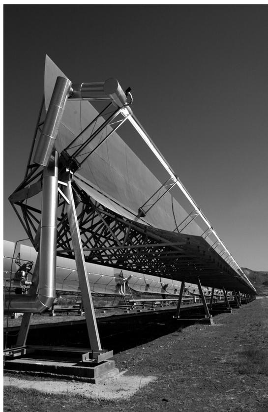
Figura 1. Vista de captador solar cilindroparábólico en seguimiento solar de la instalación DISS para la generación directa de vapor (Plataforma Solar de Almería, España).
