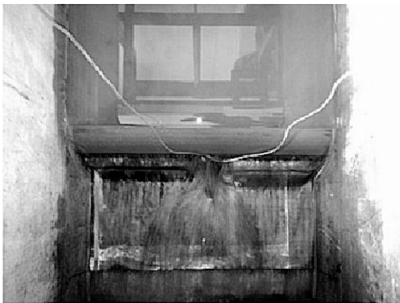
Figura 8. Cimacio ventilado mediante mangueras.
