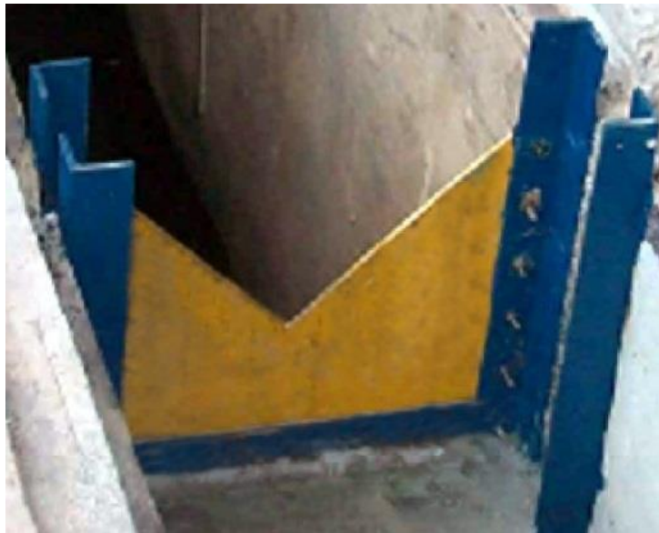
Figura 3. Vertedor de aforo visto desde aguas abajo.
