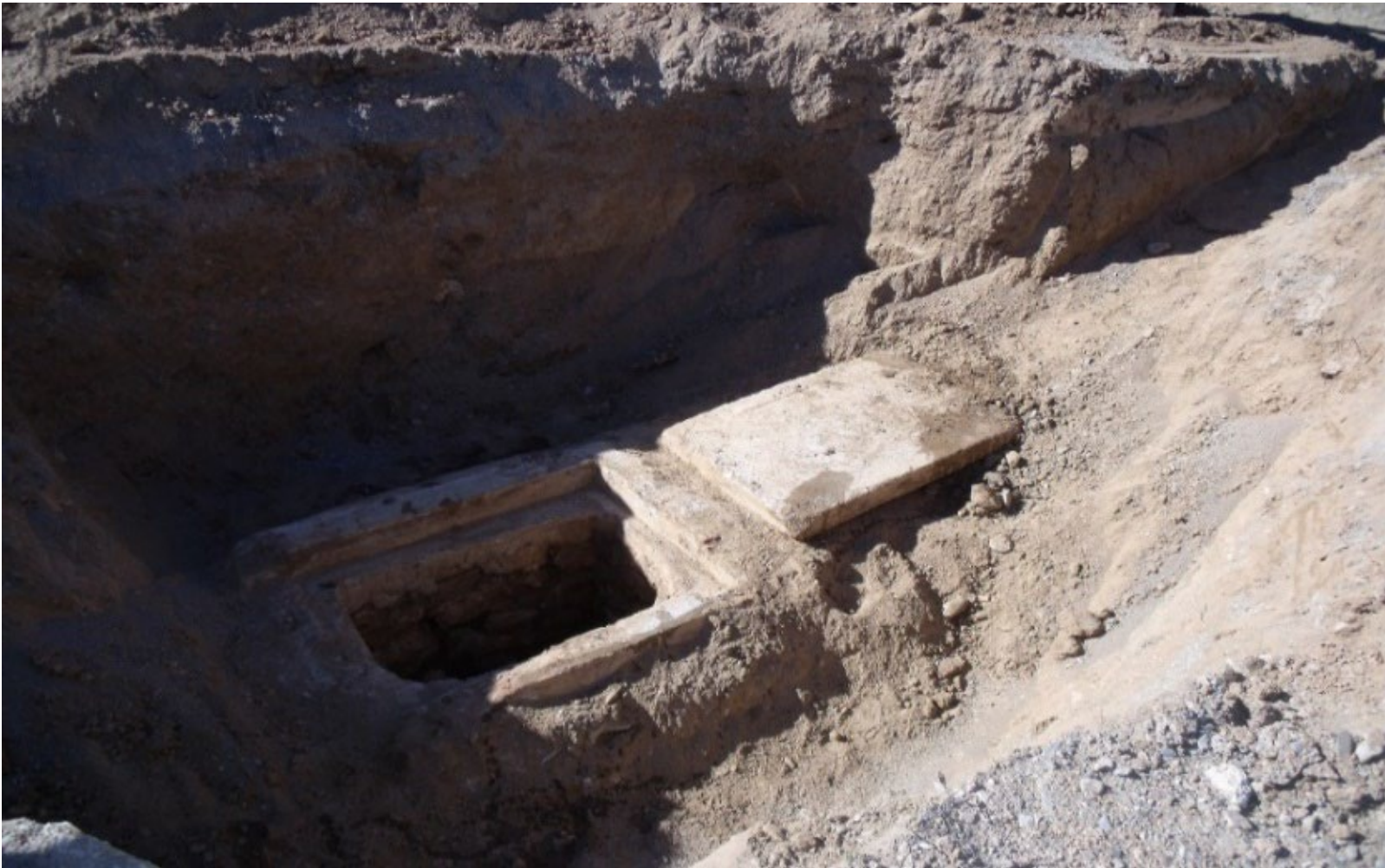
Figura 6. Lumbrera en la rambla de Nogalte, donde se unen las galerías del Caño Viejo y del Contracaño.
