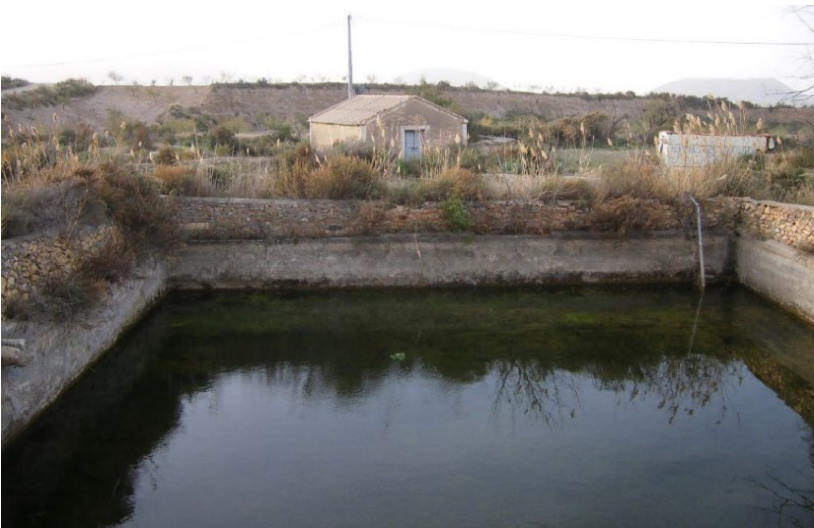
Figura 7. Balsa de la finca de Vilerda. Recibe las aguas de La Tercia, de una boquera y de un pozo vertical.
