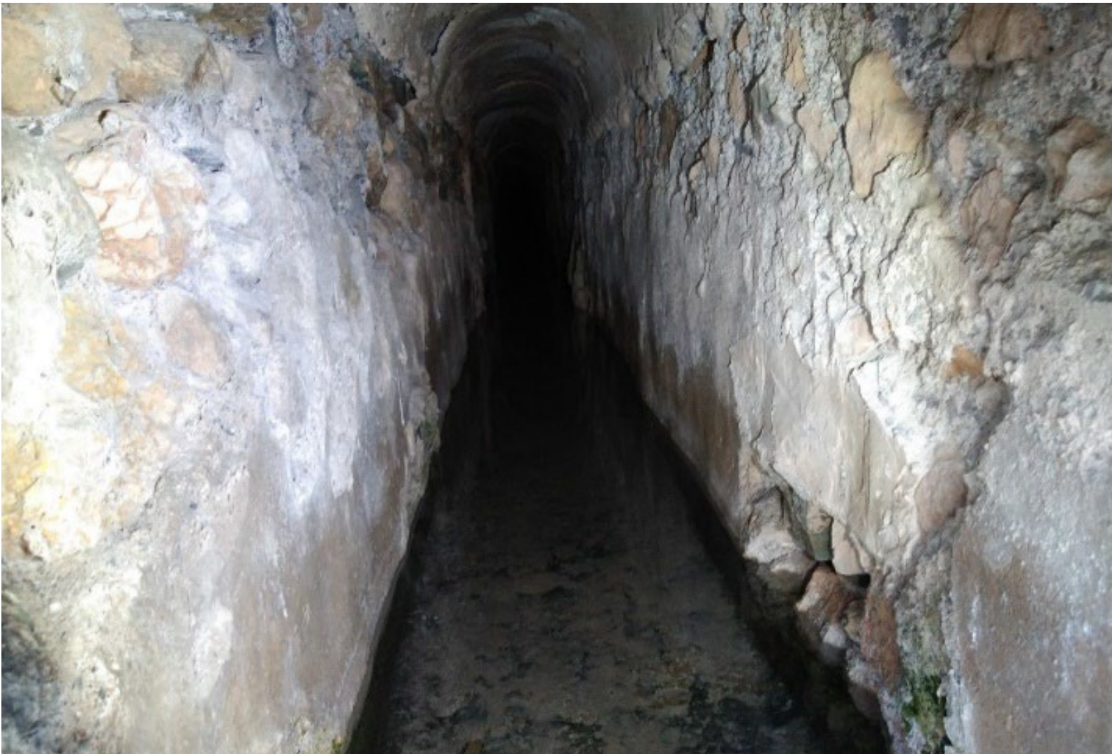
Figura 4. Interior de la galería con lumbreras de Béjar. Fuente: Pérez-Membrives (2020).
