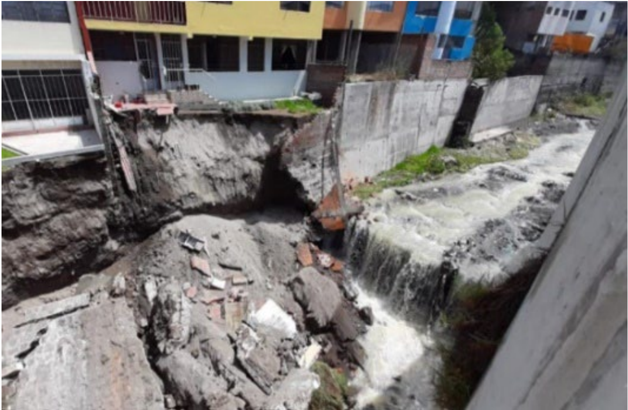
Figura 22. Fuertes lluvias desencadenan en erosión y socavación en la torrentera San Lázaro.
