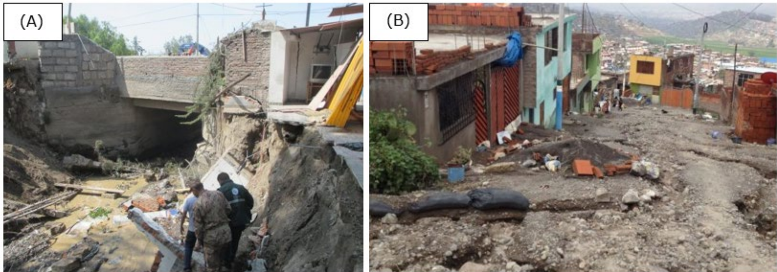
Figura 8. Registro del 8 de marzo y 30 de enero de 2017: A) colapso del Puente Concordia en la torrentera del Chulo debido a las fuertes lluvias que afectaron a la ciudad de Arequipa; B) fuertes lluvias desencadenaron la activación de la quebrada Paucarpata, produciéndose huaycos. Fuente: El Búho (2017a; 2018b).
