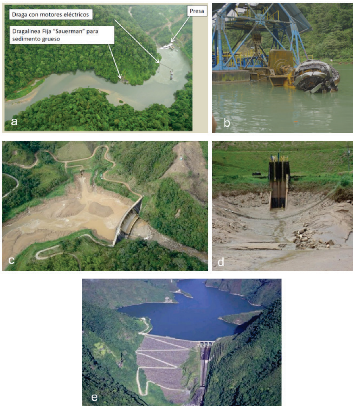
Figura 8. Aspecto de casos críticos de sedimentación en Colombia.
